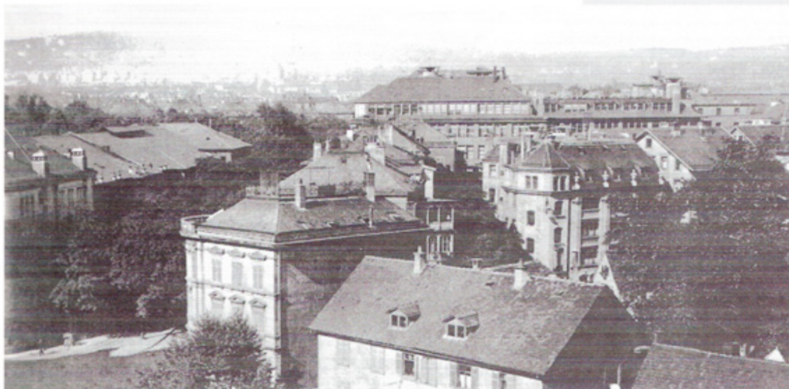
Die ersten Fabrik- gebäude (1910)
