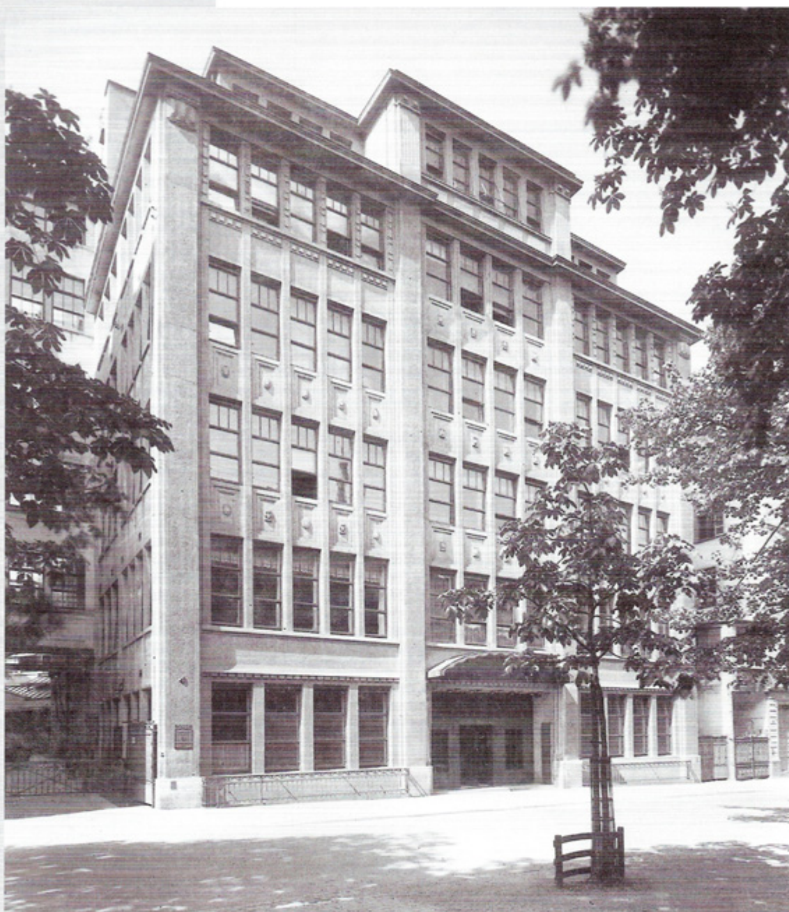
Gebäude 17 (1925), Ansicht Breitscheid- straße
