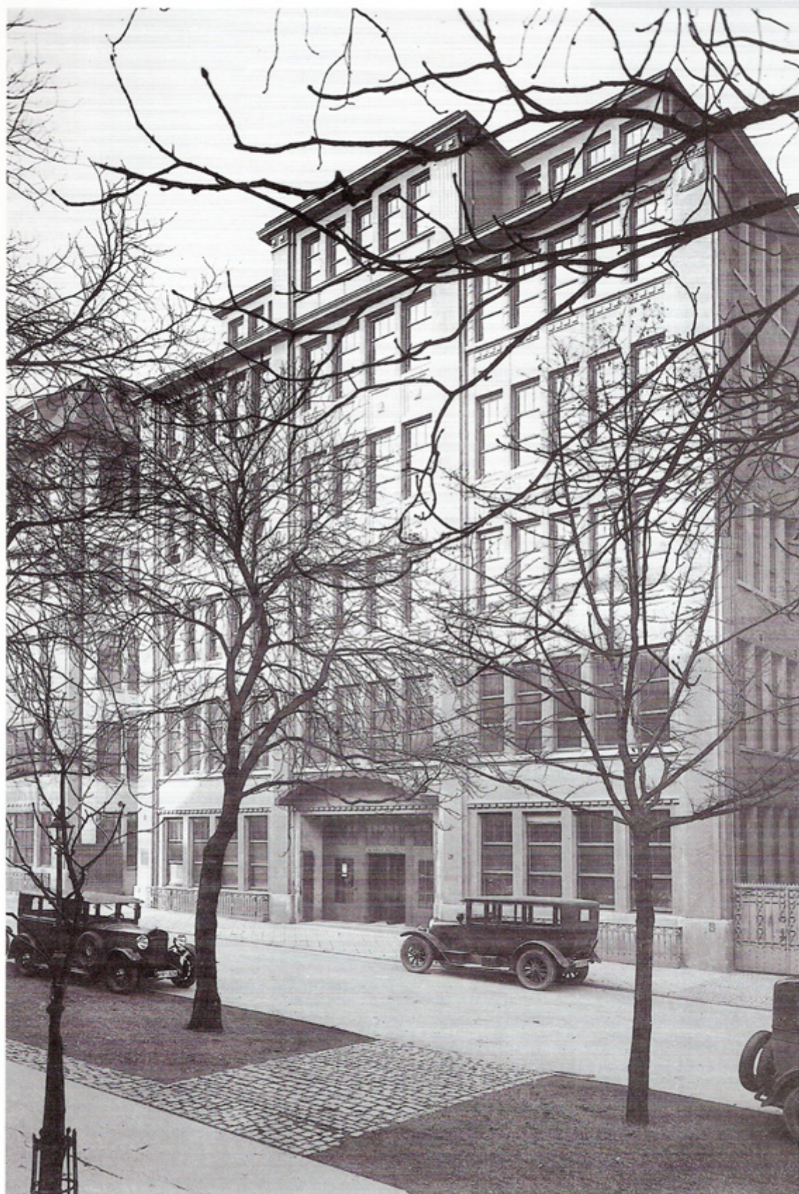
Gebäude 17 (1925), Ansicht Breitscheid- straße
